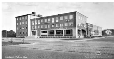
Folketshuset då det var nybyggt 1955
